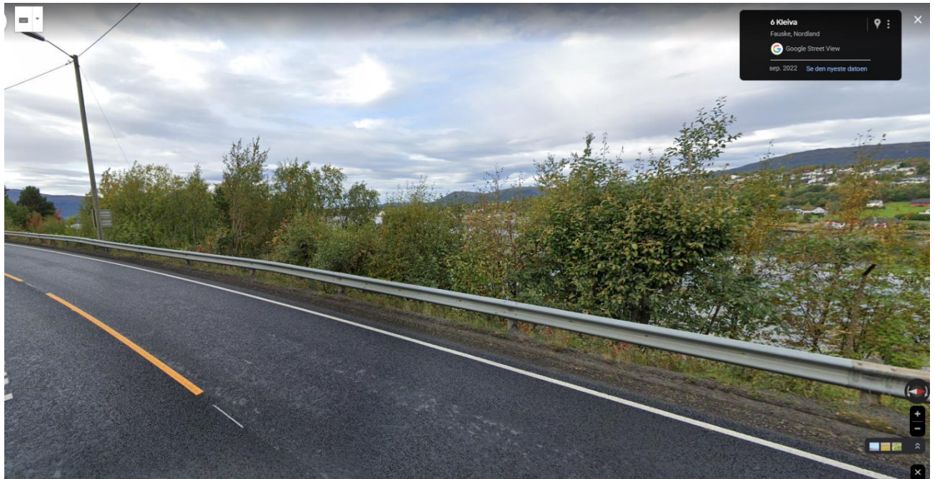
Figur 4: Kleiva før og etter, sett mot vest.
