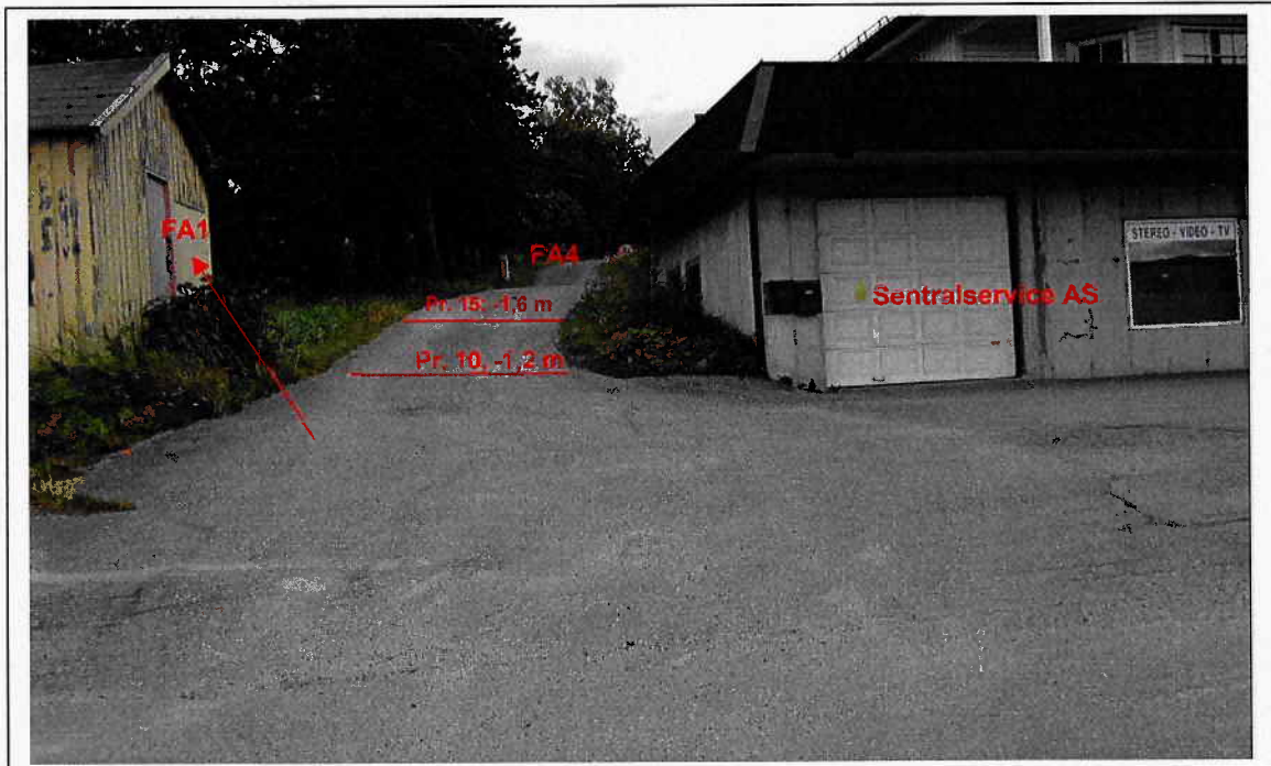
Figur 2: Avkjørsel FA4 og FA1 sett fra gang-/sykkelvegen. Senket vegnivå angitt for profil 10 og 15
