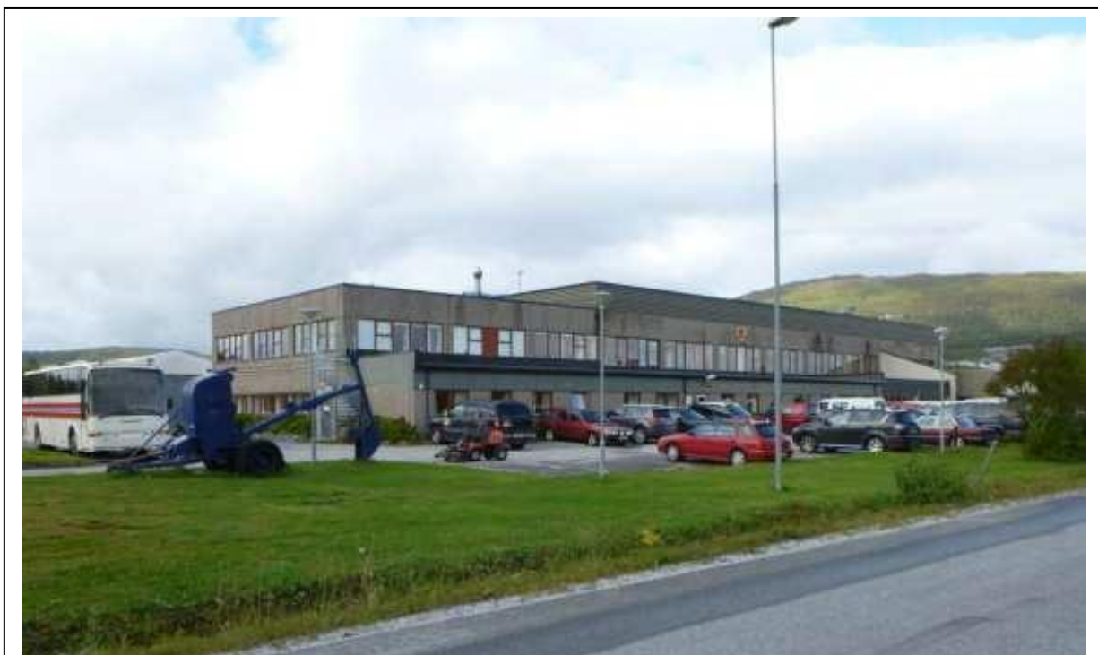
Figur 13: Videregående skole sett mot nordvest.
