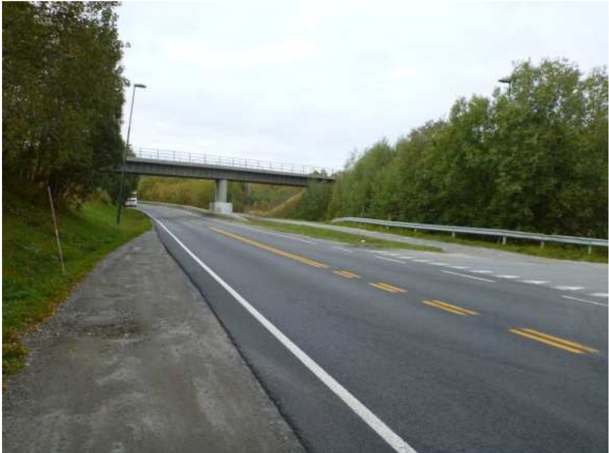
Figur 10: E6 sett mot jernbaneundergang i sør.
