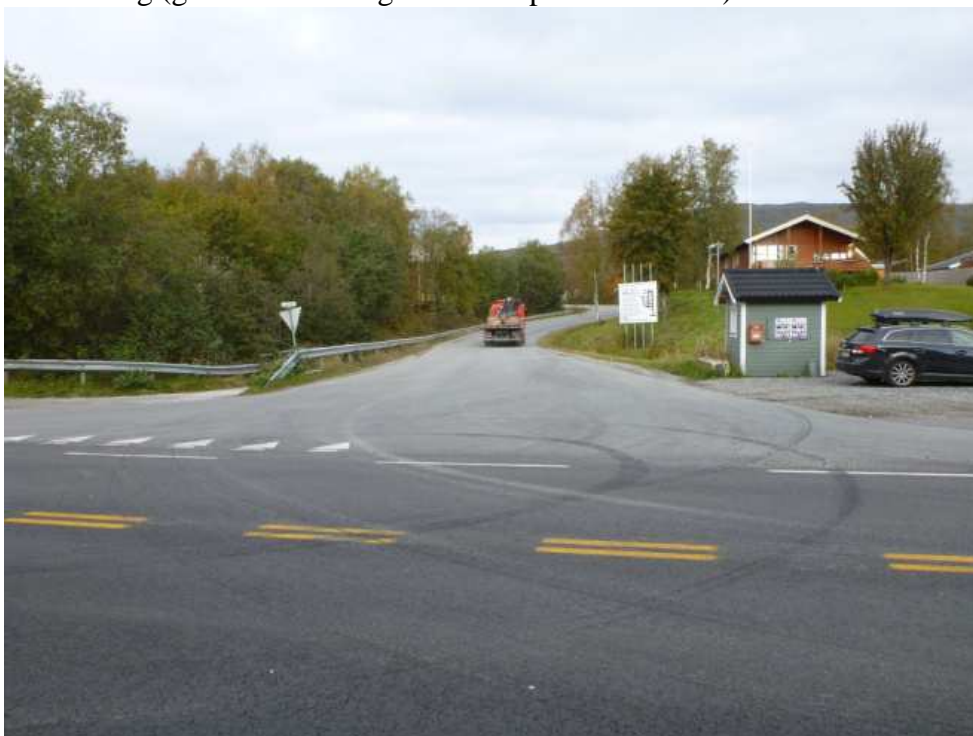
Figur 4: Kryss E6/Løvgavlveien sett mot vest.
