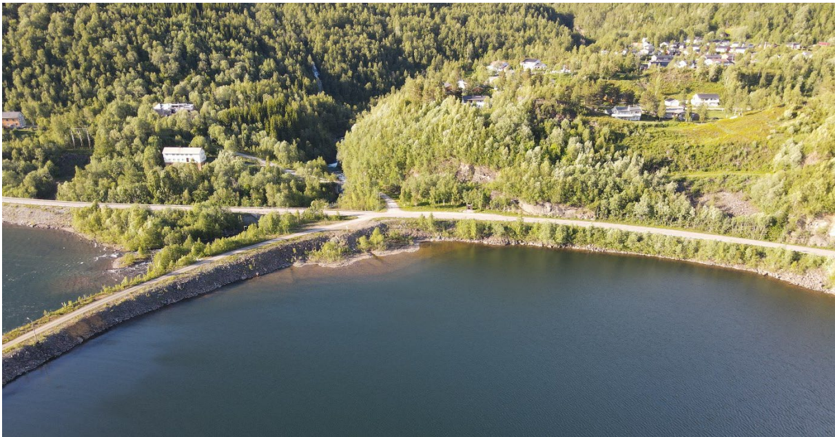
Figur 14 Veifyllingen som utgjør Avilonsveien over Langvatnet. Dette er området for gråbergsdeponi.
