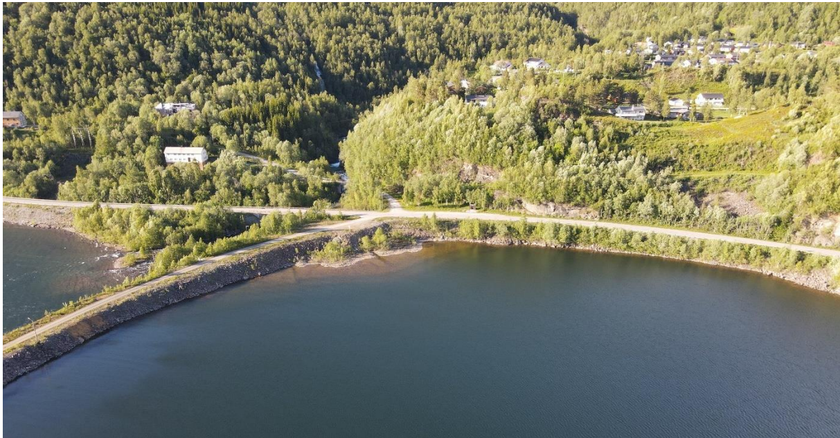
Figur 15 Veifyllingen som utgjør Avilonsveien over Langvatnet. Dette er området for steinfyllingen.
