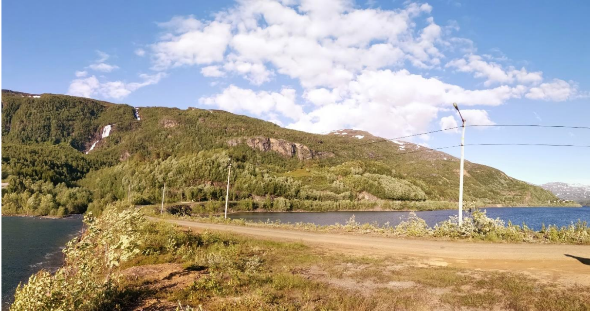
Figur 6 Eksisterende veifylling i Langvatnet, Avilonveien, og området innenfor der steimassene skal legges ut.
