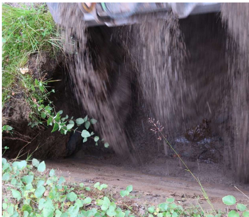
Bilde 2: Prøvehull 1 Grunnvann trenger inn ca 1,2 meter under terrenget
