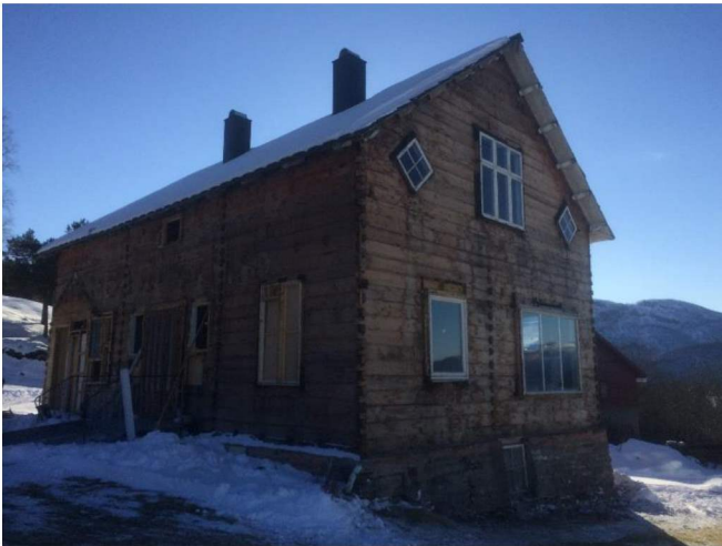
Figur 1: Tidligere bygg som ble revet i 2019.
