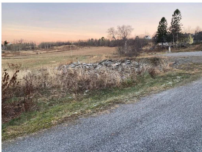
Figur 4: Fylling etter tidligere bolig
