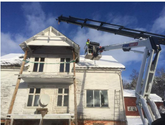
Figur 2: Frontfasade før riving.
