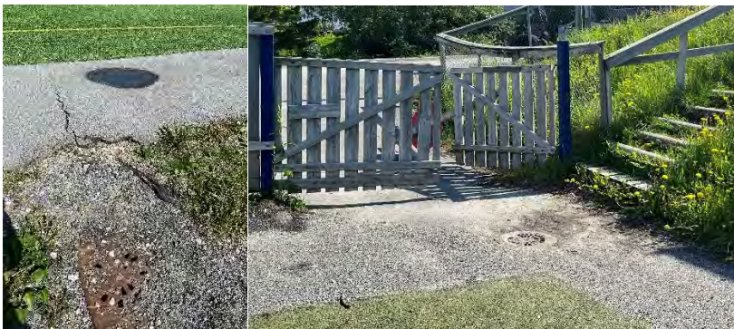
Figur 1. Sluker uten oppsamling ved Fauske kunstgressbane og Fauske stadion (foto: Statsforvalteren i Nordland).
