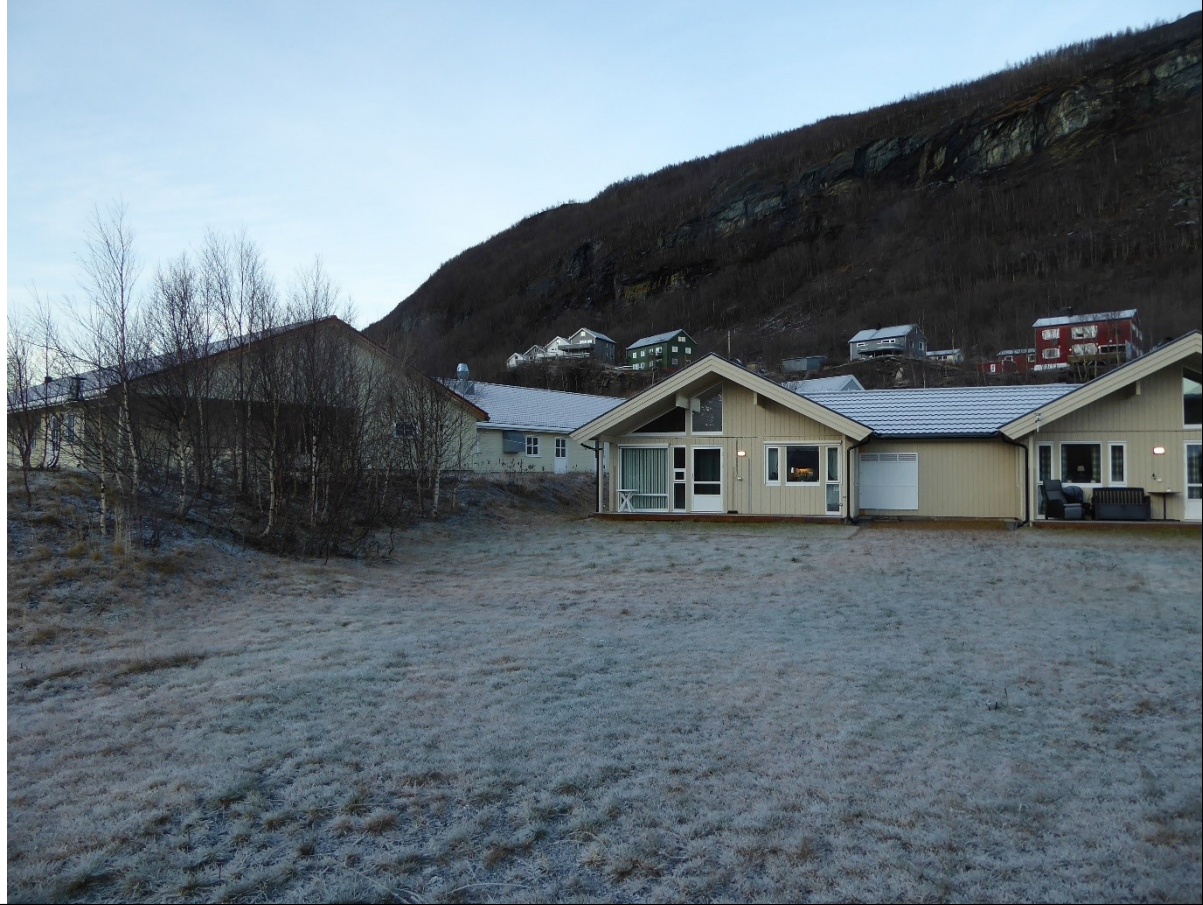
Bilde som viser Sagatun til venstre og nærmeste to-mannsbolig på Charlottatippen til høyre.
